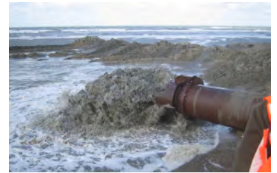
Start aanleg Maasvlakte 2
